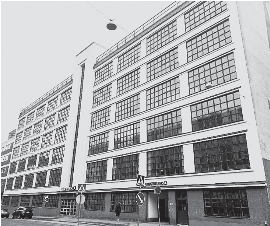
Alunperin arkkitehti Aarne Sarvelan suunnittelema, vuonna 1926 valmistunut rakennus nykyasussaan. Yrjö Jahnssonin säätiön omistuksessa 1974–2007. Kuva: Antti Suvanto
